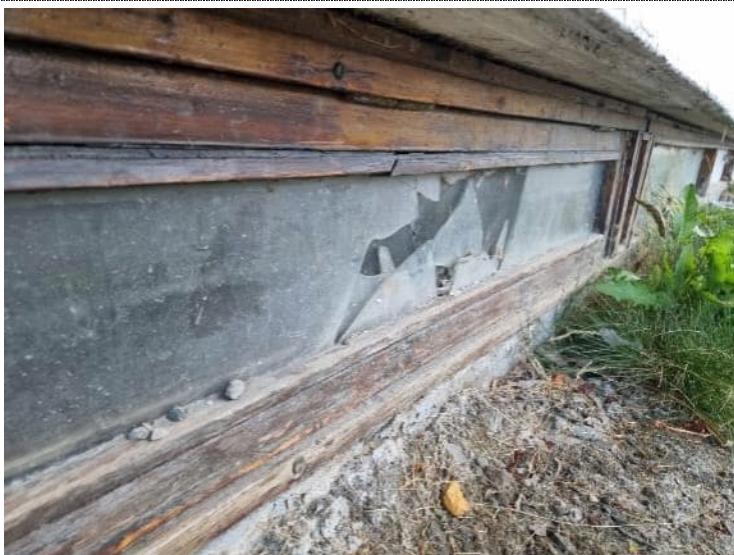
Bilde 53: B-558 Slitte rammer og knust glass kjeller mot vest
