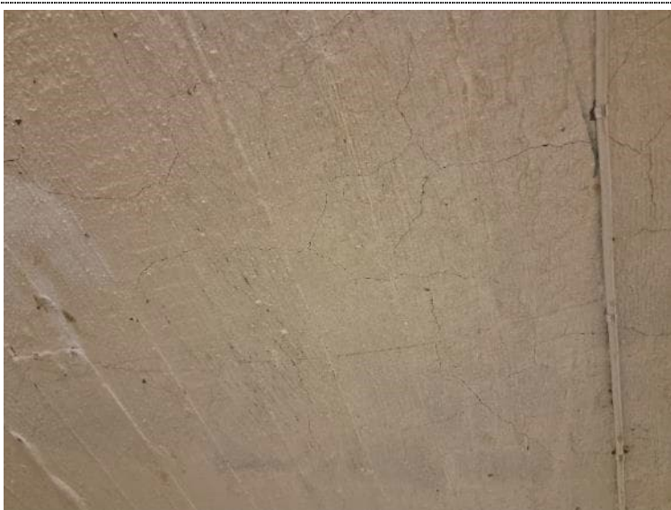
Bilde 86: B-176 Riss uk dekke plan U
