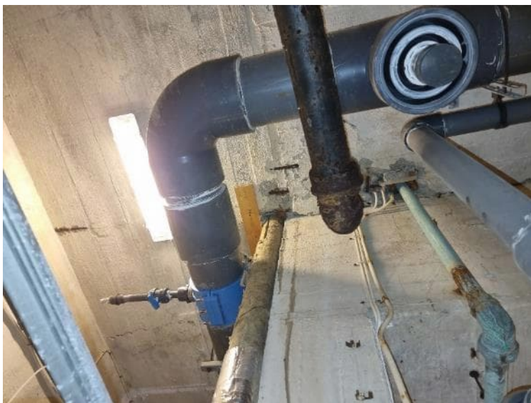
Bilde 84: B-146 Synlig korrodert armering uk dekke over plan U
