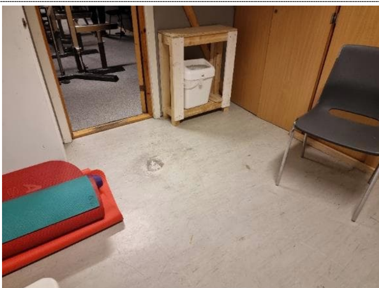
Bilde 109: B-429 Gulvoverflate plan 0 gang mot treningsrom
