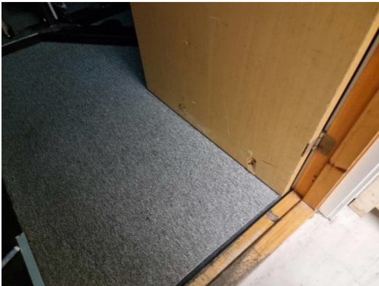
Bilde 76: B-936 Hakk i dør til treningsrom plan 0.
