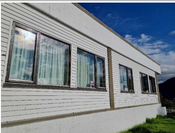
Bilde 64: B-569 Trekledning mot sør
