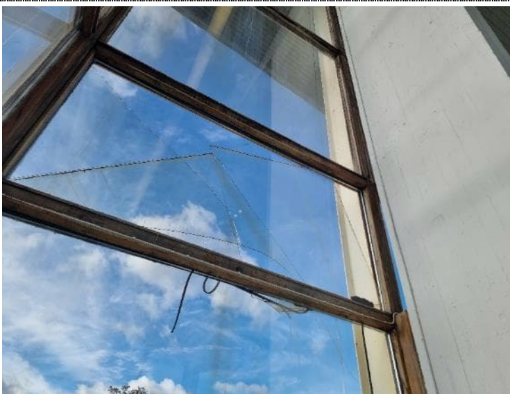
Bilde 39: B-006 Knust glass i glassfasade
