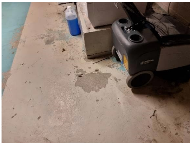
Bilde 120: B-917 Gulvoverflate vaskerom kjeller
