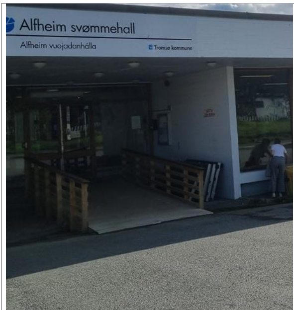
Bilde 15: Trykkimpregnert trevirke ved inngang.
