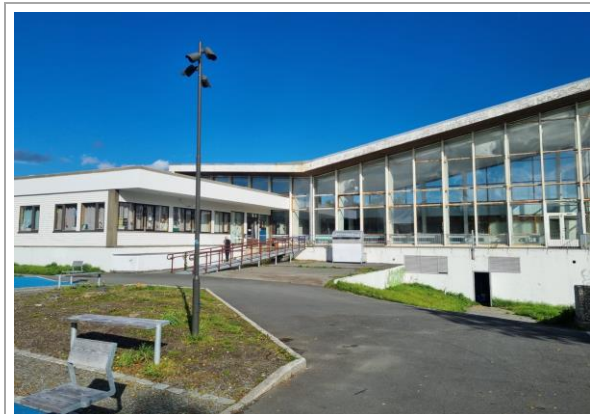
Bilde 1: Fasade mot sør
