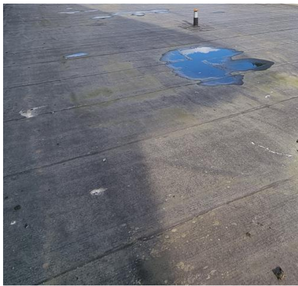
Bilde 23: Takpapp på yttertak
