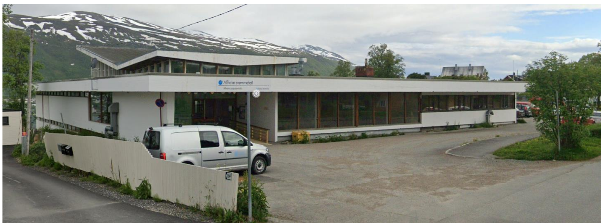
Figur 1: Fasade inngangsparti (google maps)
